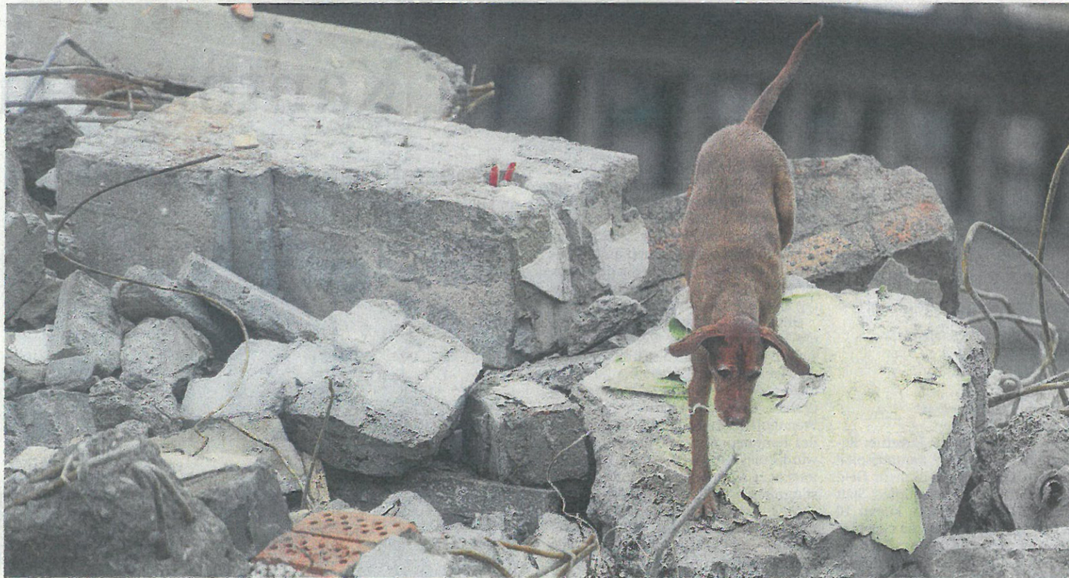
Hündin Nanya sucht auf der Himmelrich-Baustelle in Luzern nach unter dem Schutt vergrabenen Menschen.
